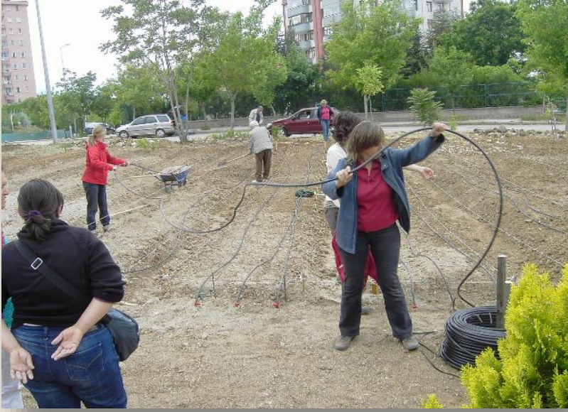
Damlama sulama tesisatı kurma ve deneme çalışmaları.
